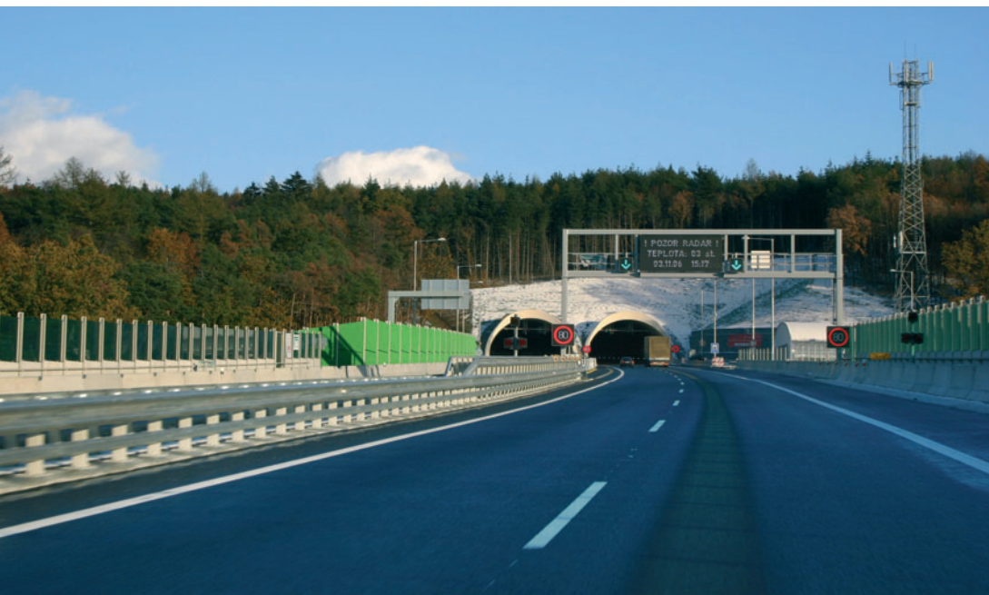
■ Dálniční tunel Valík
