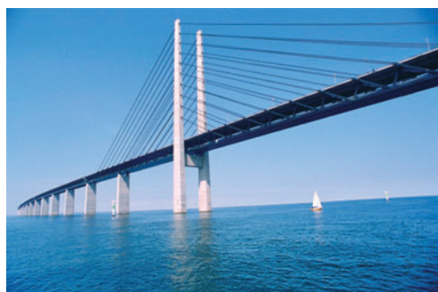
■ Pierre Mens: Pohled z hladiny – malý člun projíždí pod vysokou částí mostu
