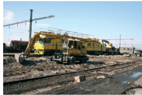
■ Úprava svahu vedľa trate
