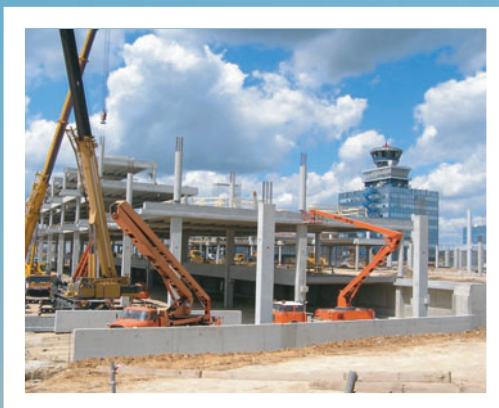
■ Výstavba nového terminálu
