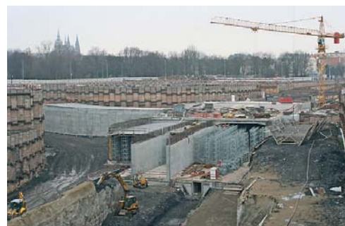
Staveniště na Letné, s Hradčany a stadionem Sparty v pozadí
