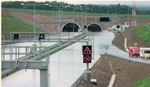
Stavba 513 Cholupické portály
