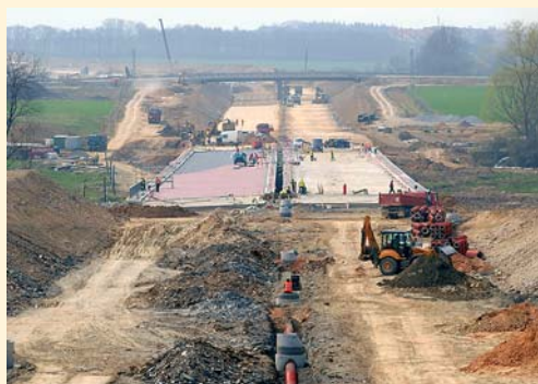
Stavba 512 Hlavní trasa u Modletic
