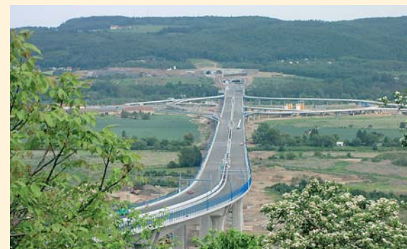
Stavba 514 Estakáda přes údolí Berounky
